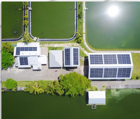
ITDC BALI : 95 kWp
