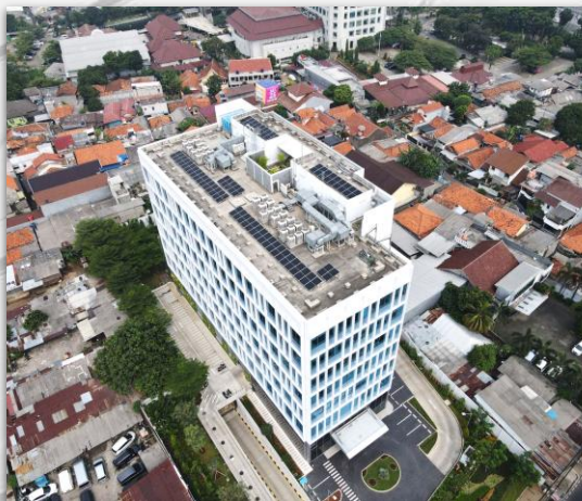
BAF JAKARTA : 32 kWp
