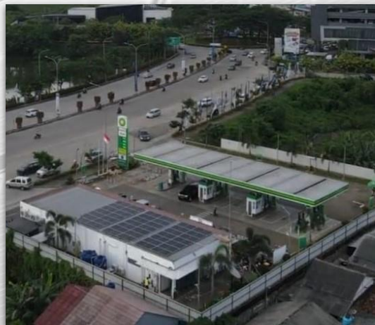
BP AKR METLAND : 23 kWp
